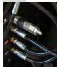
Tlaková zkouška dusíkem
